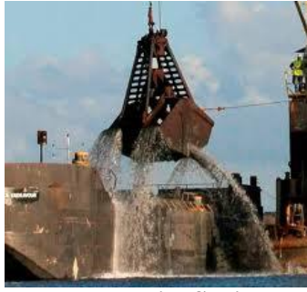
Gambar Pengangkutan Material Sedimen di Kolam Pelabuhan.
