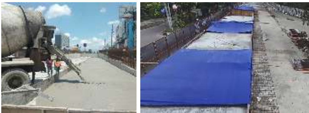
Gambar 1. Proses Penghamparan Mortar busa (Sumber : Dokumentasi prbadi,2021)
